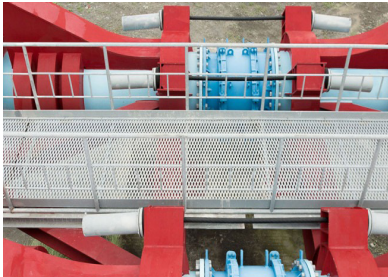
高架管道人行走道
